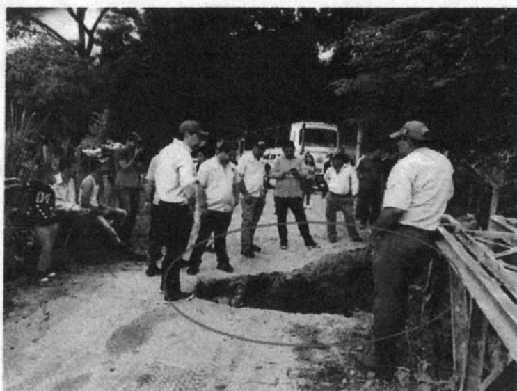
Foto 13. Perdida de Bancada.
