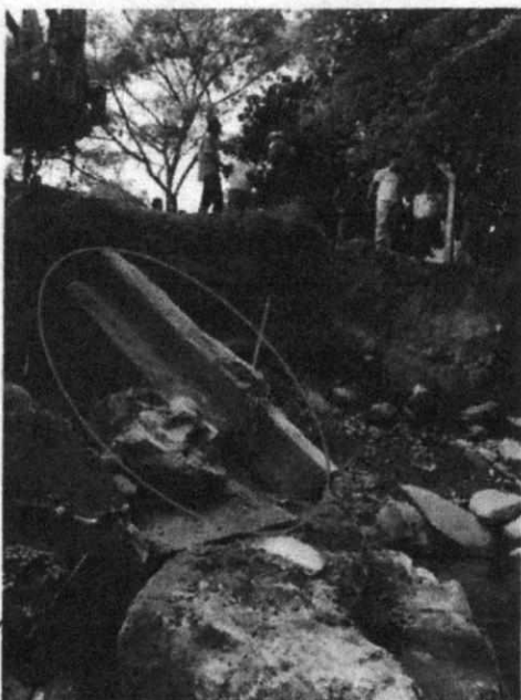
Foto 16. Viga del Estribo.
